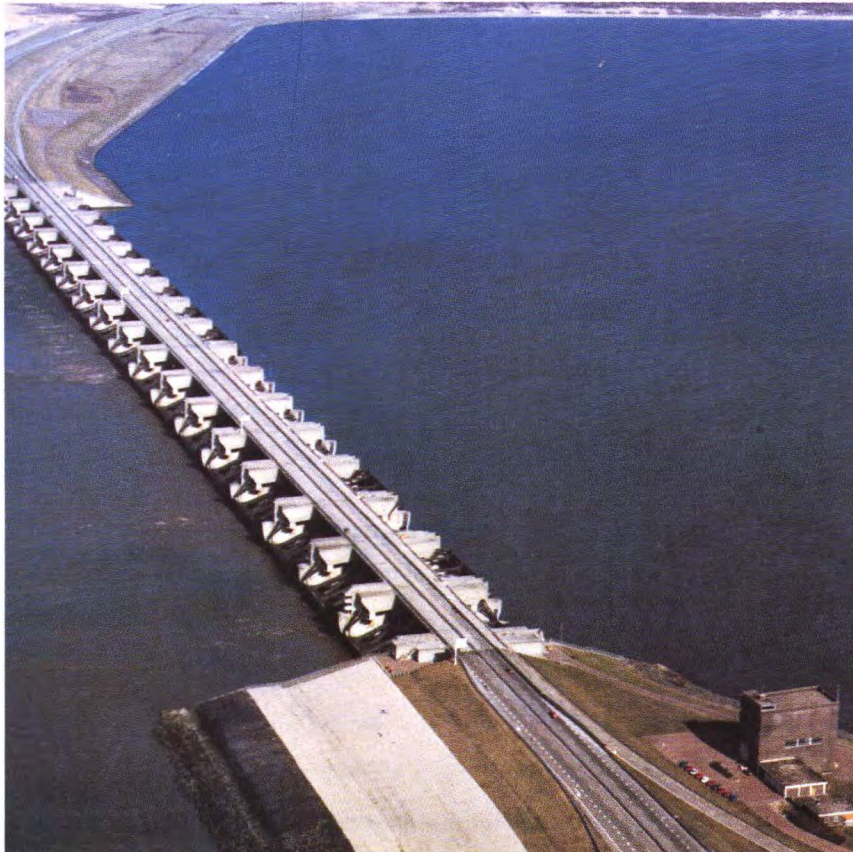
Presas de Haringoliet 1971
