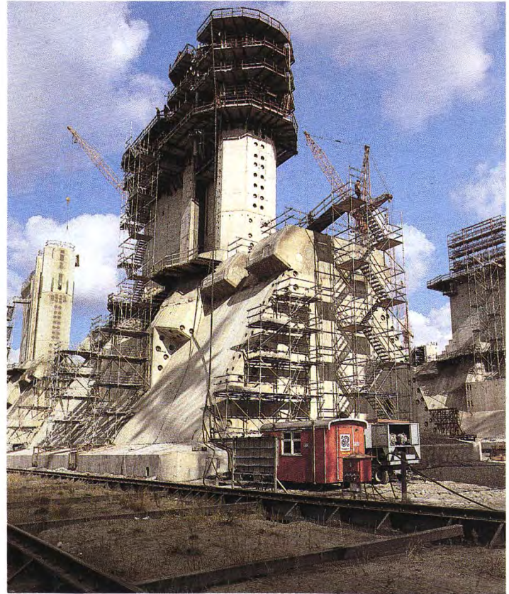
Ejecución de una de las pilastras
