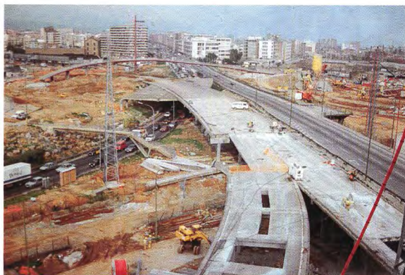
Plaza de las Glorias (Barcelona). Técnica: Disco de diamante, gatos hidráulicos y pinza demoledora.
