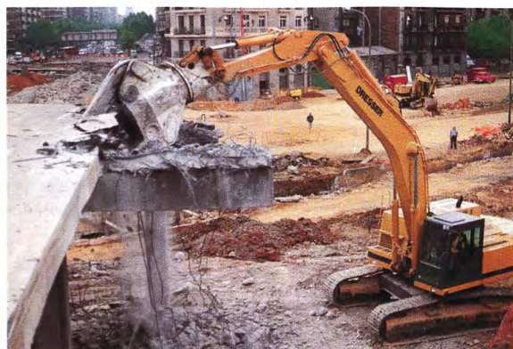
Demolición de hormigón. Técnica: Pinza demoledora.
