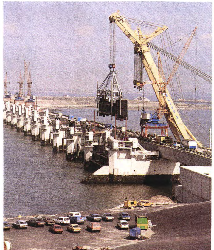
Colocación de una compuerta desde el barco-grúa, Taklift IV
