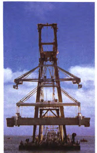
La construcción de la barrera anti-tempestad requirió el diseño y construcción de barcos no usuales. Vistas del Ostrea, Macoma y Taklift
