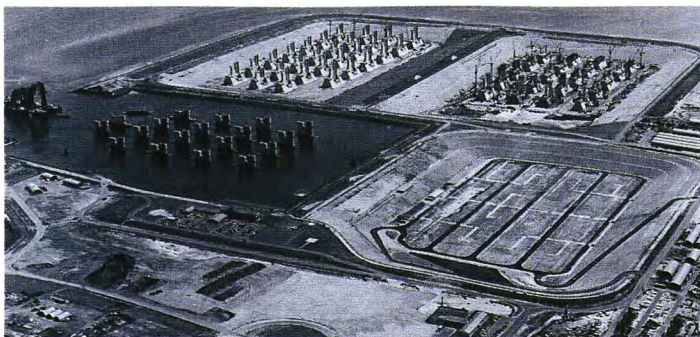
Dársenas de construcción de las pilastras
