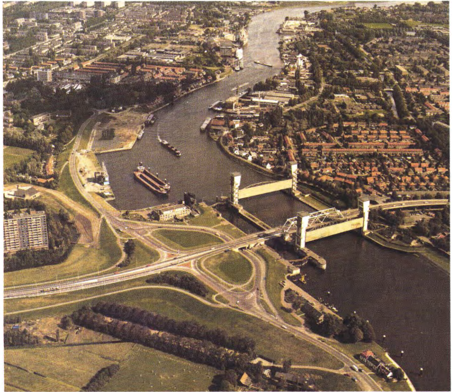
Presa de Zandkreek . 1960
